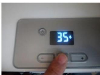
Далее клавишами "+" или "-" выбираем значение "D.43" и нажимаем кнопку "MODE". Устанавливаем нужное значение и выходим из сервисного меню, удерживая кнопку "MODE" или кнопку сброса ошибки, которая находится сверху и слева от дисплея.
